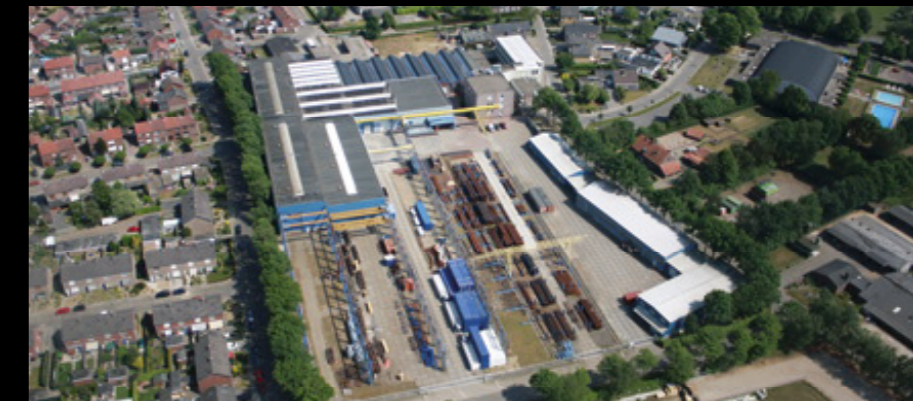
Production facility Vlodrop направляющих труб.
